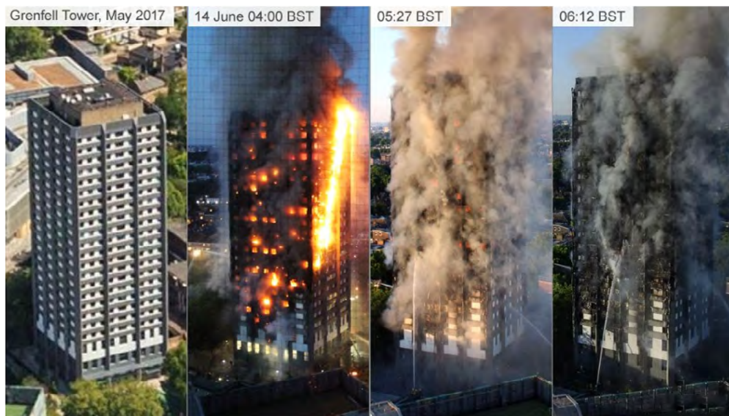
Slika 1 Izgled zgrade Grenfell prije i tijekom požara [7]
