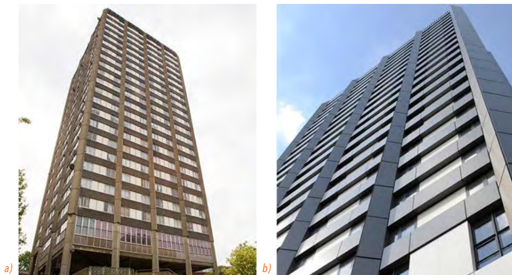
Slika 4 Zgrada Grenfell a) prije i b) poslije energetske obnove pročelja [10]
